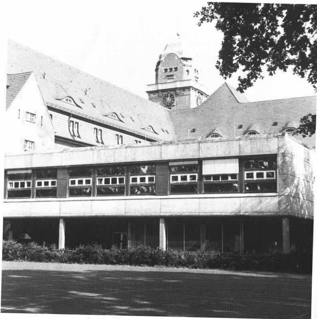
So verschandelt der Anbau den Blick auf die Rückfront der Schule
