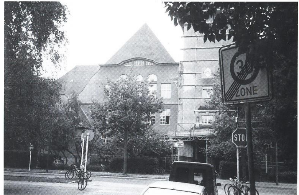
Blick auf den linken, noch nicht renovierten Flügel des AGD
