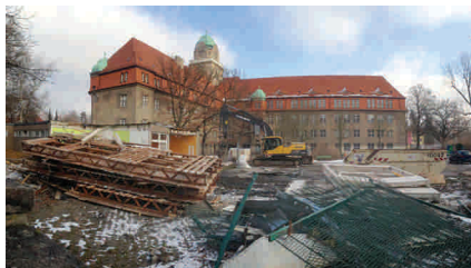
Abriss des alten Gartenhauses
