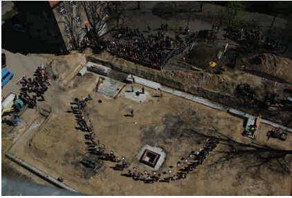
Grundsteinlegung (vom Baukran aufgenommen)
